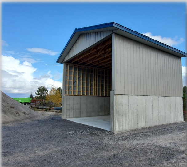
Entrepôt pour les sels de voirie
